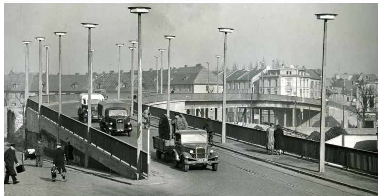
Die 1905 vollendete Viktoriabrücke wurde 1944 zerstört und 1949 innerhalb von fünfeneinhalb Monaten wiedererrichtet, ohne daß eine Diskussion über die Namensgebung anhub.
